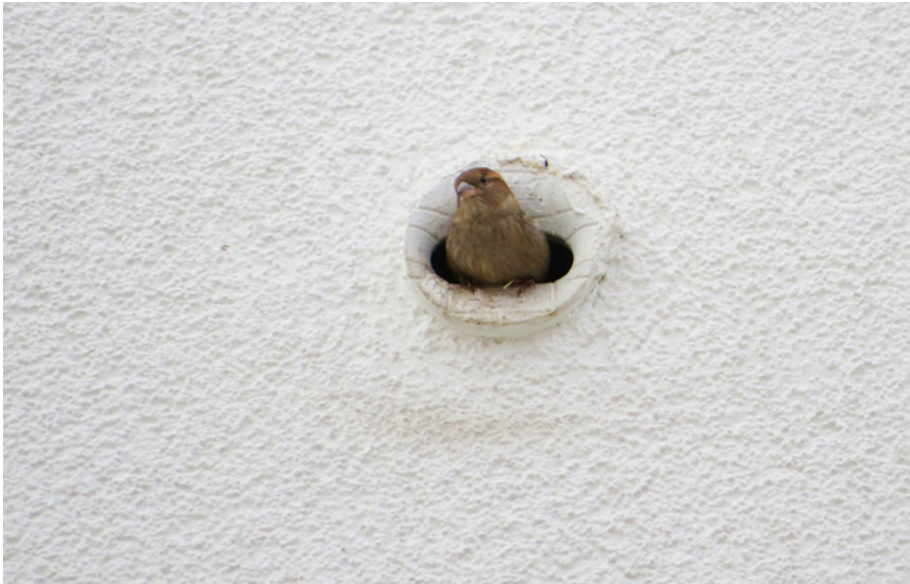
Nisthilfen für Gebäudebrüter lassen sich problemlos in die Fassade integrieren. (Foto: Mirjam Nadjafzadeh)
