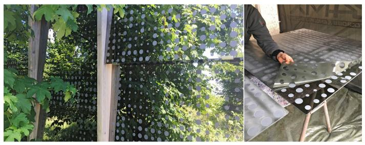
Eine nachträglich sandgestrahlte Fassade in Scharnstein: Für die Nachrüstung konnten die einzelnen stark spiegelnden Gläser von der Fassade abgenommen werden. Anschliessend wurden sie vor Ort durch partielles Sandstrahlen (lochkartenartiges Punktraster wechselnder Durchmesser) im Sinne des Vogelschutzes verändert.
