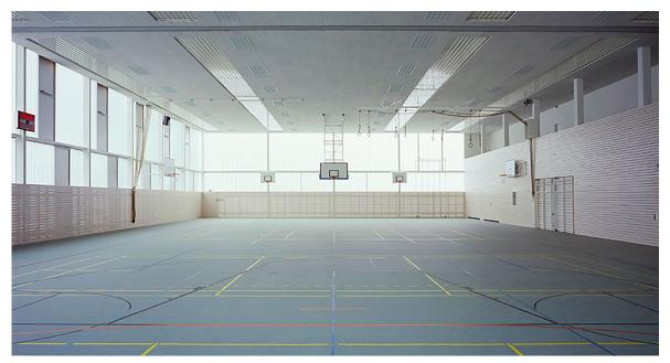
Die Gebäudehülle der Ballspielhalle Ingolstadt von Fink+Jocher besteht aus einer Profilbauglaskonstruktion, die zwischen ihren beiden Glasprofilschalen mit transluzenter Wärmedämmung gefüllt ist. Diese sorgt für ausreichend Lichteinfall ohne störende Schlagschatten auf dem Spielfeld.
