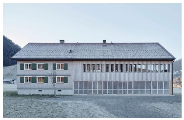
Im Zuge einer Umnutzung haben gruber locher architekten bei der Sanierung des denkmalgeschützten Hauses Grossenbündt in Hittisau die Erschliessungsflächen hinter einer semitransparenten Raumschicht zusammengefasst. Die Struktur der traditionellen Holzfassade wird aus Sonnenschutzgründen über die langen Fensterbänder im Obergeschoss weitergeführt, während die klassischen Kastenfenster des Wohntraktes erhalten blieben. Vögel können diese Materialien und Strukturen gut erkennen.
