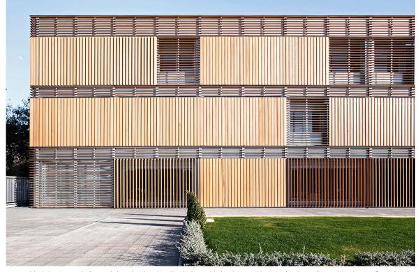
Im Westblock des Centre d'Idiomes de la Universitat de València des Architekturbüros Arkítera SLP bestimmt die Kombination von feststehenden und beweglichen Sonnenschutz-Lamellen die Fassadenstruktur.
