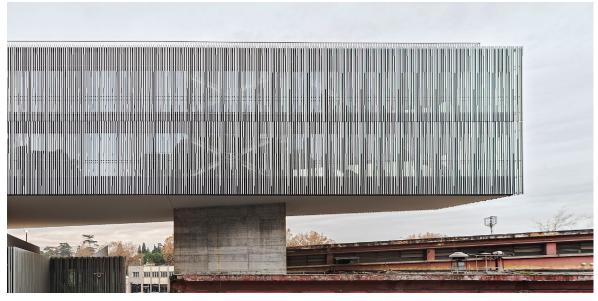
Die Città del Sole («Sonnenstadt») in Rom des Architekturbüros Labics ist eine Mehrzweckanlage mit öffentlichen und privaten Funktionen. Sowohl die Fassadengestaltung aus Aluminiumprofilen als auch die transluzenten gläsernen Lamellen an den unterschiedlichen Gebäuden sorgen gleichermassen für Sonnen- wie auch für Vogelschutz.
