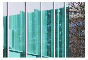
Die Kollisionsspuren zeigen deutlich, dass getöntes Glas keinen Anprallschutz bietet.
