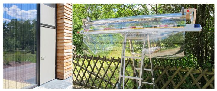
Bedruckte Folien werden vollflächig aufs Glas aufgebracht.
