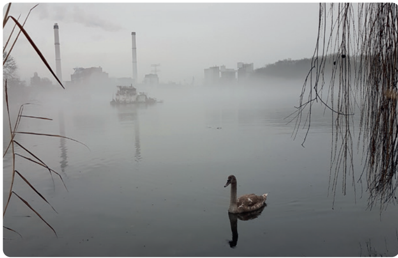
Nebulös: Soll im Kraftwerk Klingenberg Holz für Fernwärme verbrannt werden? Foto: Sebastian Petrich
